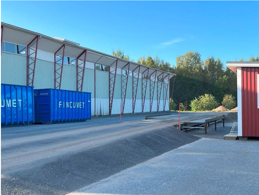
Kuva 14. Autovaaka ja takana lajitteluhalli kuvattu 15.9.2023.
